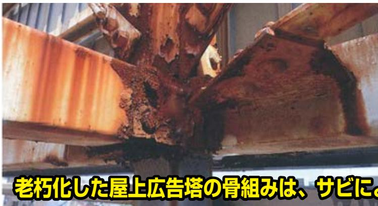
老朽化した屋上広告塔の骨組みは、サビによる腐食でポロポロに。もしも落下したら…
