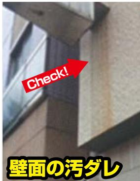
壁面にサビなどの汚ダレが見られる場合は、ブラケットがサビで腐食しています。ひどい場合は看板が落下する恐れがあります。また、板面や押え枠のゆがみ、ボルトやビスなどの落下があったら、看板全体の点検・補修をしないと危険。高所からの看板の落下は、人命にかかわる事故につながります。ただちに専門業者に依頼を！
